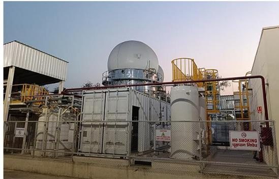
Die voll funktionsfähige Pilotanlage produziert Biogas aus Napiergras, einem robusten mehrjährigen Gras aus der Familie der Poaceae, das direkt auf dem Werksgelände in Manesar angebaut wird. Zusätzlich wird ebenfalls Biogas aus den Lebensmittelabfällen der Werkskantine gewonnen. Das gereinigte und aufbereitete Gas wird dann wiederum zum Kochen in der Kantine und für den Produktionsprozess verwendet. Die Rückstände werden als organischer Dünger für den internen Gartenbau verwertet.
